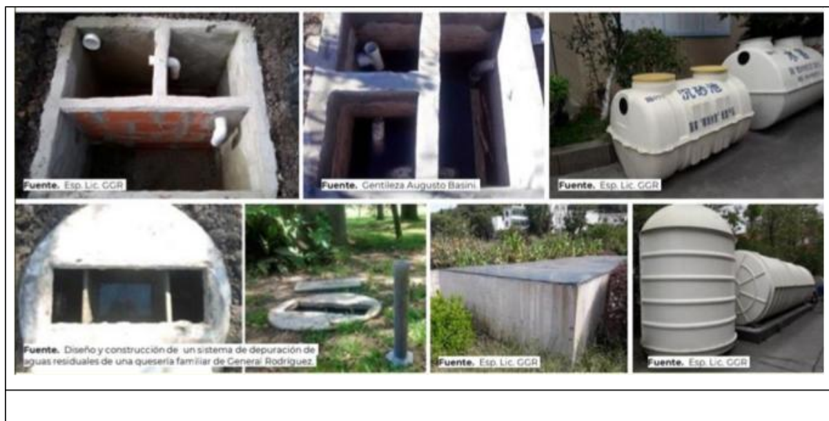
Imagen 3 - Cámara Séptica – Distintas variantes - Fuente: INTI Gustavo Ruhl
